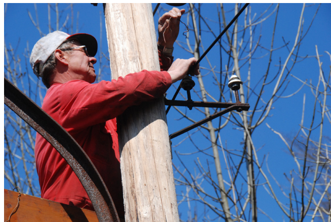
Das Bild zeigt Wolfgang Thier im Rahmen von Fahrleitungsarbeiten am 11. April 2009 auf dem Turmwagen, den er selbst konzipiert und gebaut hatte. Der rote Overall war gut zehn Jahre lang sein Markenzeichen. Foto: Albin Michlmayr
