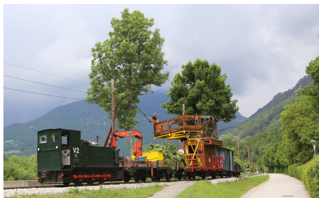
Der Fahrleitungslchtraumfreischnitt wurde unter anderem am 8. Juni 2023 durchgeführt. Foto: Albert Malli
