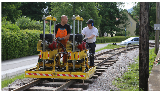
Am 6. Juni 2023 wird auf der Gleisbaustelle bei Reichenau von Reinhard und Florian mit der Stopfmaschine gearbeitet (oben) und der restliche Schotter ausgebracht (unten). Fotos: Albert Malli
