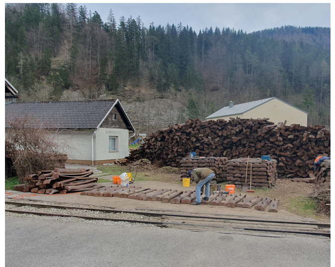
Vom großen Haufen im Hintergrund werden die Schwellen geholt, vor dem Lokschuppen in Lunz abgeplattet, die Schrauben anschließend aufgearbeitet und die Schwellen währenddessen sauber gestapelt. Foto: Ingo Wiener
