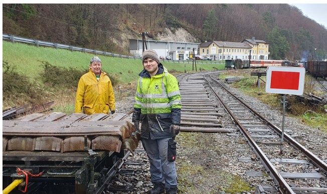
Am 17. April waren die ehrenamtlichen Mitarbeiter trotz Regens beim Gleisbau im Bahnhof Kienberg-Gaming tätig. Die Stahlschwellen sind bereits ausgelegt und das Kleiseisen am Umfahrgleis abgebaut. Foto: Ingo Wiener
