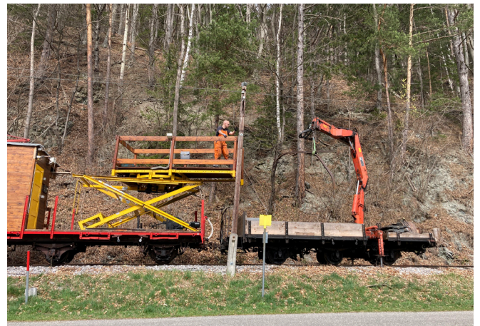
Am 25. März 2023 wurde der Sturmschaden an der Fahrleitung bei km 4,6 repariert; Reinhard ist gerade mit den Arbeiten am Ausleger fertig geworden. Foto: Florian Strobl
