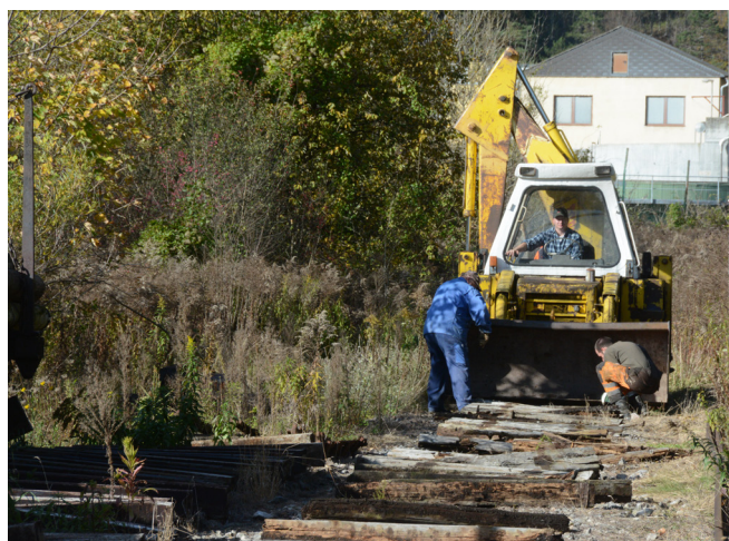
Am 7. November ist der Abbau des ehemaligen Gleises in Hirschwang in vollem Gang: Erich und Ferdinand laden die Altschwellen die Schaufel des Baggers, der von Florian gesteuert wird. Foto: Albin Michlmayr
