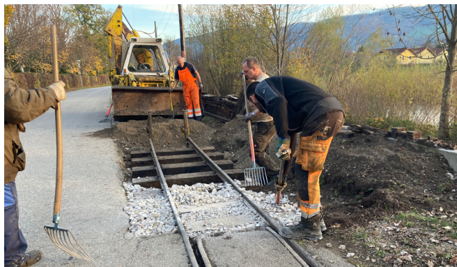
Nach dem Abbau der Schienen werden am 8. November die ersten sechs neuen Schwellen der Baustelle eingebaut. Foto: Florian Strobl
