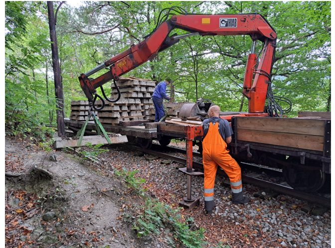
Am 17. September werden am Artzberg bei km 1,8 die Betonschwellen für einen zukünftigen Einbau ausgelegt. Auch hier leistet der Kranwagen wichtige Dienste. Foto: Ferdinand Drexler
