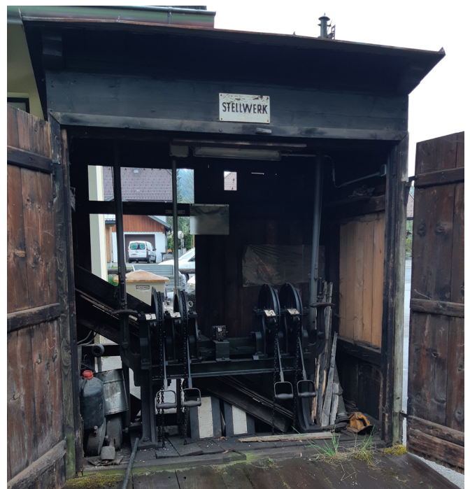
Das Stellwerk von Göstling vor dem Abbau. Foto: Stephan Rewitzer
