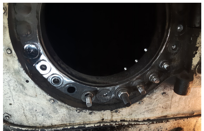
Ausbau der Niete des Türnings mit zur Bohrung angezeichneten, aufgebohrten und bereits entfernten sowie entfernten und mit Gewindestangen verschraubte Nietlöchern. Foto: Stephan Rewitzer
