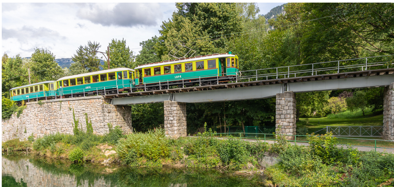
Am 20. August überquert der Triebwagen TW I mit den beiden Beiwägen die Kurhausbrücke. Foto: Martin Zigler
