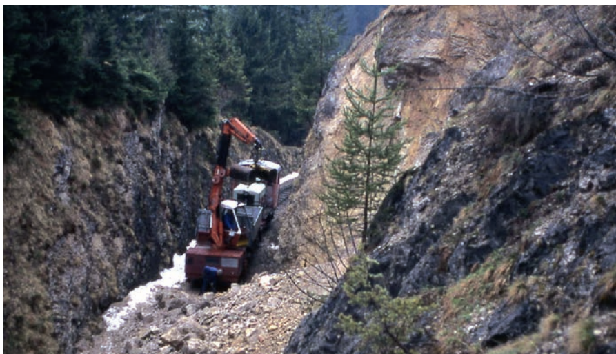
Vor 25 Jahren verschüttete Ende des Winters ein Felssturz die YB-Strecke am Beginn des Hufeisenbogens bei Bodingbach. Im April 1987 konnte der selbstgebaute Kranwagen BEW 1 in mehrtägiger Arbeit die Strecke wieder freimachen. Foto: Werner Schiendl
