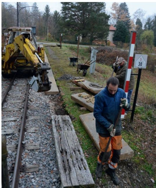
Hochbetrieb in der Haltestelle Kurhaus am 15. November 2021: Während die bisherigen Altschwellen für das Ausheben vorbereitet werden, bereiten sich Erich und Florian (im Bagger) bereits für das Einheben der nächsten Betonplatte vor. Foto: Albin Michlmayr
