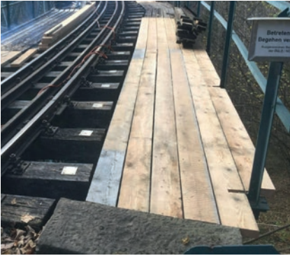
Am 1. November wurde die Brückenbedie- lung bei der Hühnernebstbrücke erneuert. Foto: Reinhard Mestan
