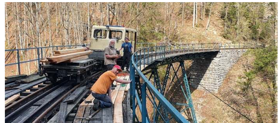
Es wurde schließlich das erste Maiwochenende, an dem wir endlich einen Teil des Bauholzes für die Wetterbachbrücke von Pfaffenschlag zur Baustelle befördern konnten. Foto: Ingo Wiener
