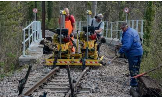
Die Betonschwellen werden gestopft. Foto: Albin Michlmayr
