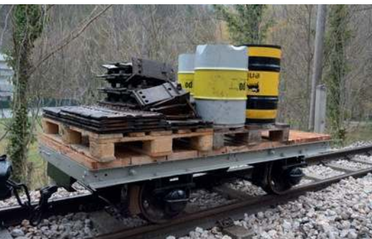
Der sanierte Bahnmeisterwagen X73 bei der Gleisbaustelle unterhalb der Kurhausbrücke.
