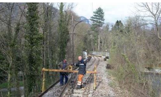
Mit unseren Schienenkränen konnten drei Schienenlängen mit nur drei Mann manipuliert werden. Foto: Albert Malli
