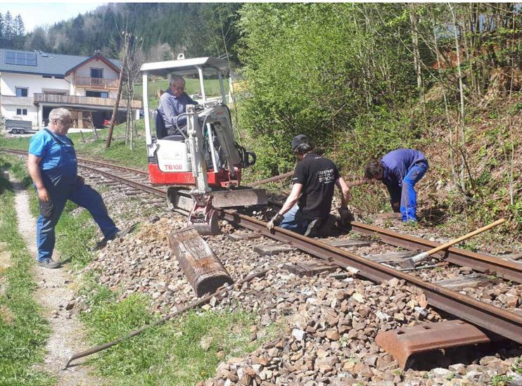
*Maschinelle Unterstützung beim Einzel-schwellentausch: Ein Minibagger zieht die alte Holzschwelle hinaus und schiebt die neue Stahlschwelle in das freie Fach.
