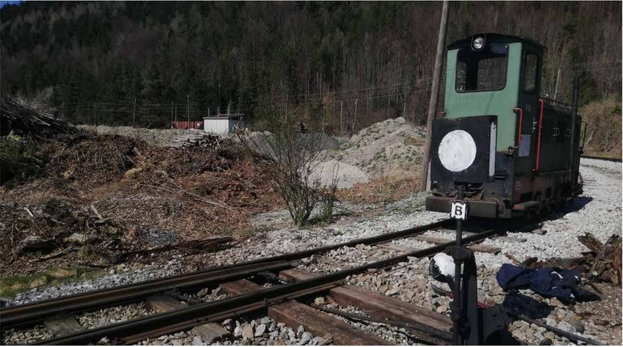
*Die beiden Hallenzufahrtsgleise wurden vergangenen Herbst komplett saniert. Die Schwellen der anschließenden Weiche „B“ wurden inkl. der beiden langen Bockschwellen heuer getauscht.
