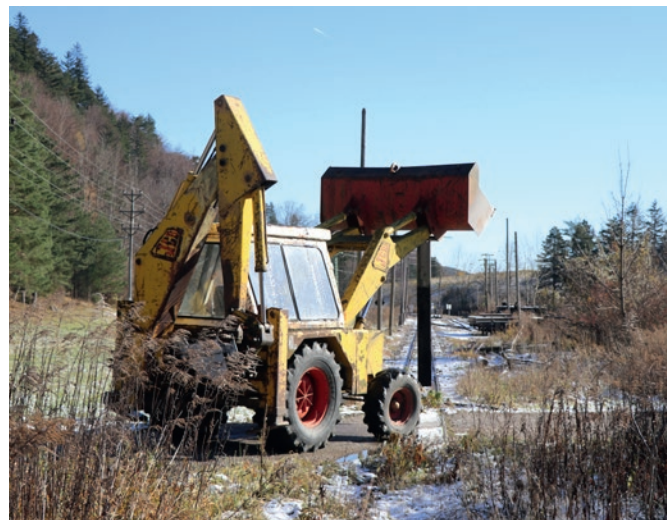
Ein Apostel wird am 21. 11. 2020 per Bagger vom ehemaligen Bahnhof Hirschwang zum Lagerplatz transportiert.
