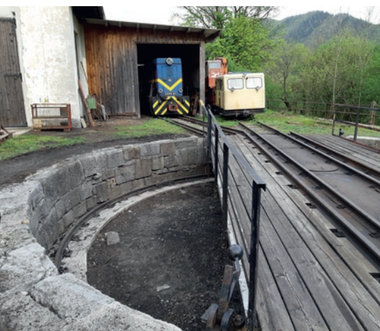
Gereinigte Drehscheibengrube. Foto: Stephan Rewitzer
