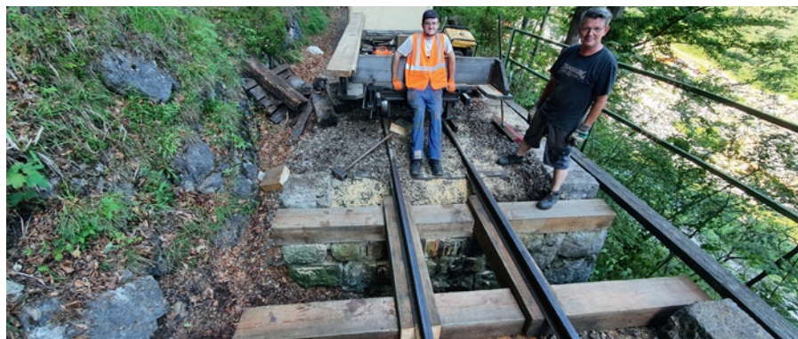
Am 12. Juni 2020 wurden die Quer- und Längsträger erfolgreich eingepasst. Foto: Ingo Wiener
