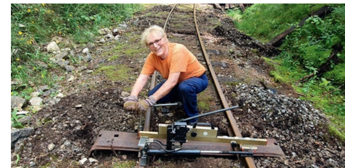
Für einen harmonischen Bogenverlauf werden die Gleise vor dem Verschrauben genau vermessen. Foto: Ingo Wiener
