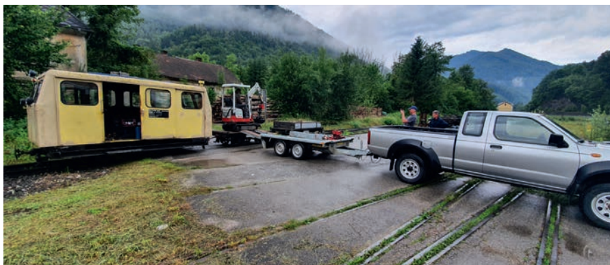
Der Minibagger wurde über die Rampen des Anhängers, mit dem er transportiert wurde, auf einen Draisinenwagen verladen. Foto: Ingo Wiener
