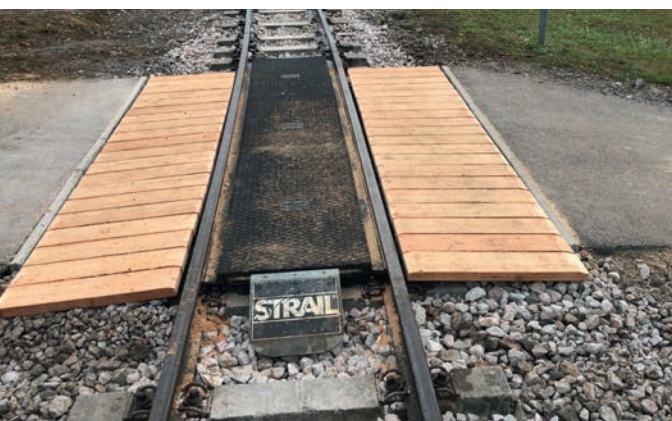
Gute Zusammenarbeit bei Fußwegübergang: In Gleismitte Gummipplatten der Firma Strail verlegt, die wir bei der Pinzgaubahn erwerben konnten, links und rechts vom Gleis hat der Bauhof Reichenau eine neue Holzbohlung eingebaut. Foto: Ferdinand Drexler
