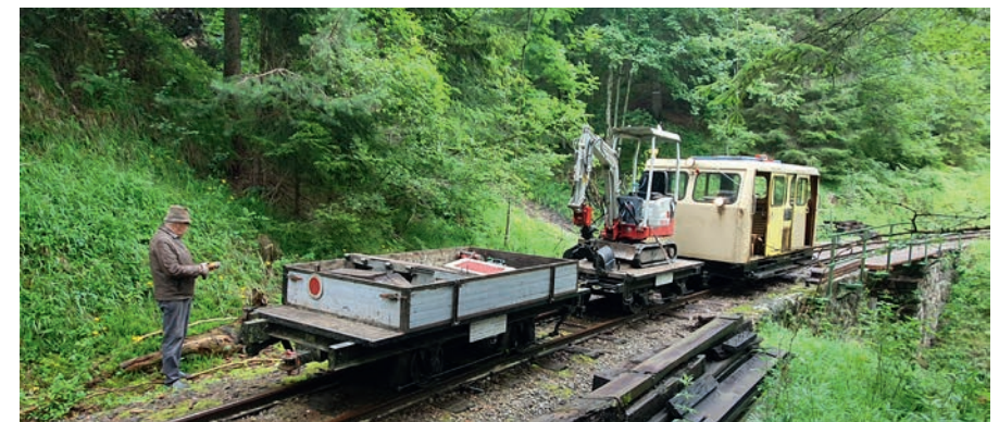
Der Bauzug ist bei der Holzriesenbrücke angekommen. Foto: Ingo Wiener
