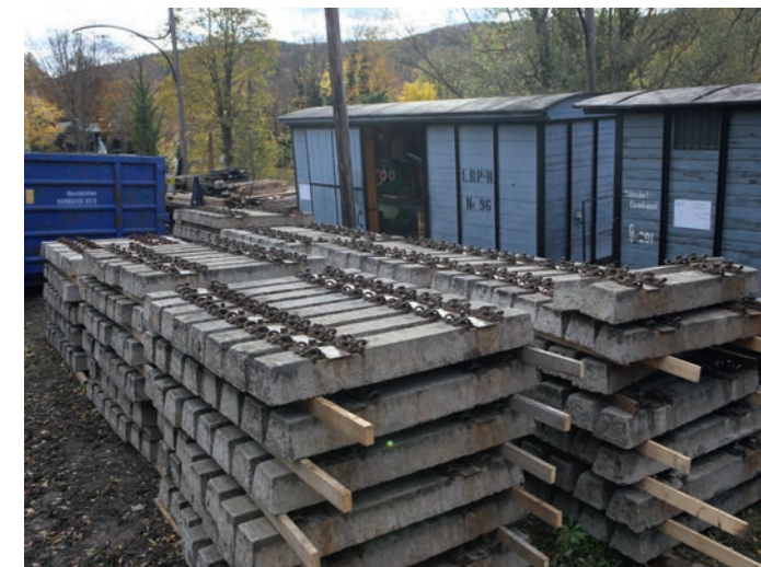
In Reichenau warten die Betonschwellen, die erst kürzlich bei der Pinzgaubahn ausgebaut wurden, auf den Einbau. Foto: Albert Malli
