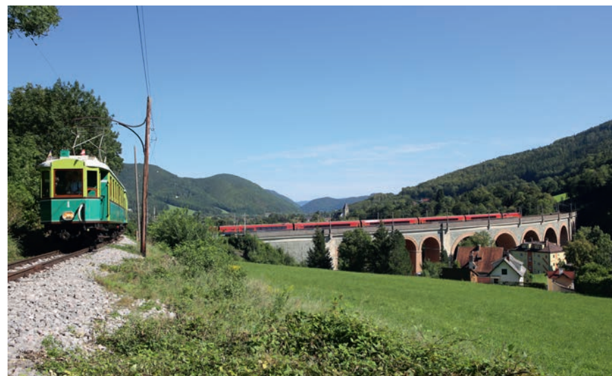
Dieses Bild gelingt nicht alle Tage. Triebwagen 1 der Höllentalbahn in Fahrtrichtung 1 Richtung Hirschwang und im Hintergrund ein Railjet auf dem Schwarza-Viadukt der Südbahn. Foto: Albert Malli
