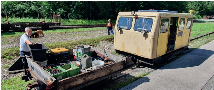
Der Gleismontage-Bauzug im Bf. Kienberg mit zwei Mal zweibeinigen und zwei Mal vierbeinigen Gleisbauarbeitern. Foto: Ingo Wiener
