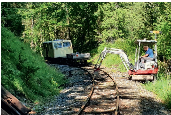
An diesem Samstag konnten wir bis zur EK bei km 63,6 60 Holzschwellen entfernen. Foto: Ingo Wiener
