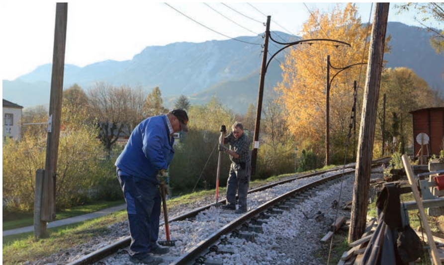
Die zwei „Althasen“ Erich und Hans haben schon vor 31 Jahren die ersten Betonschwellen bei der Höllentalbahn verlegt und waren bei der Gleisbauwoche im Herbst 2020 wieder dabei. Foto: Albert Malli
