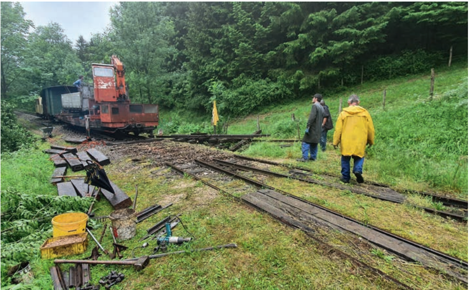
Feuchtföhliche Baustelle Holzapfel. Foto: Ingo Wiener
