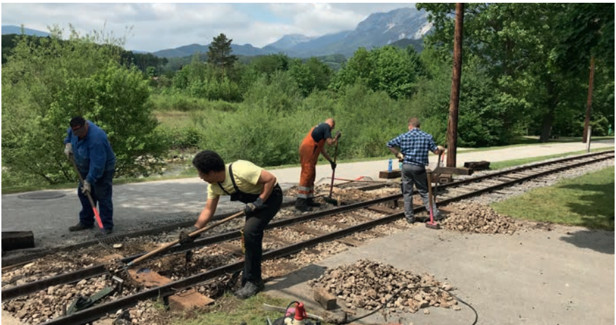
Sieben von zehn neuen Schwellen sind bei der Querung Karlon bereits eingebaut. Foto: Ferdinand Drexler.
