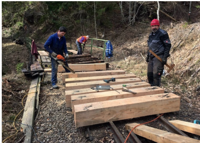
Anpassen der Überhöhung an den Schwellenhölzern mittels Motorsäge.
