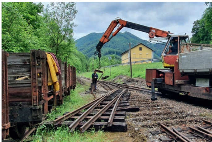
Ausbau Weiche 27. Foto: Ingo Wiener
