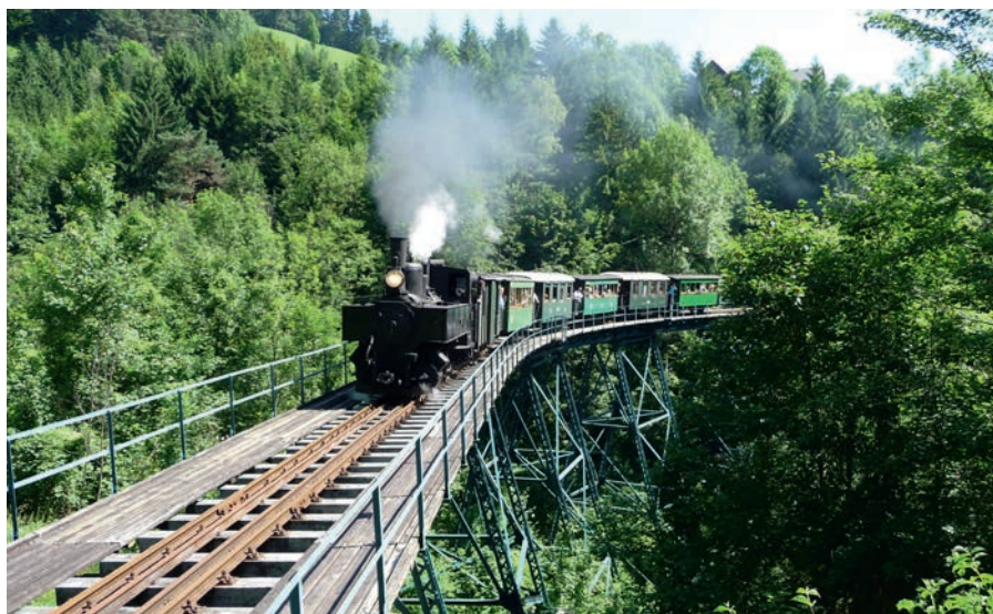
Klassische Aufnahme des Ötscherland-Express mit der Dampflok Uv.I auf dem Hühner-nest-Viadukt 2015.
