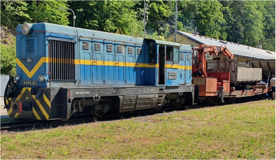
Abfahrtsbereiter Bauzug für Umbau Weiche 1 der Halte- und Ladestelle Holzapfel. Foto: Ingo Wiener
