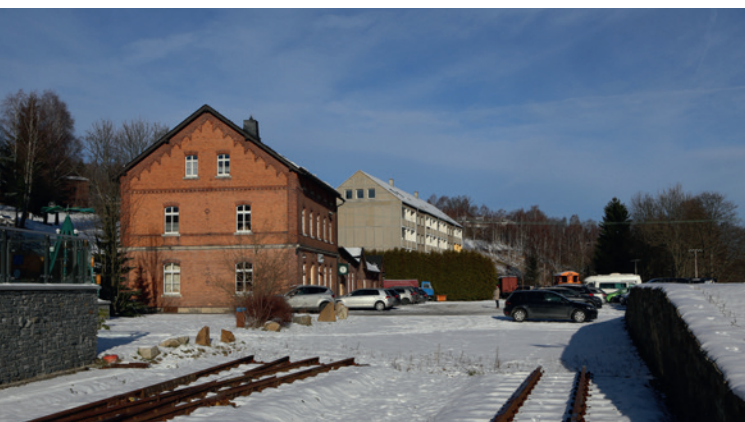
Im Bahnhof Jöhstadt soll die ursprüngliche Gleislage wiedererrichtet werden. Noch steht ein Plattenbau mitten am Bahngrund diesem Vorhaben im Weg; der Abriss ist fix geplant. Foto: Albert Malli
