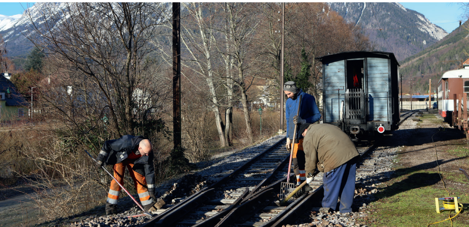
Schwellentausch in Handarbeit bei der Weiche 1 in Reichenau am 12. Jänner 2020. Im Hintergrund der malerische Blick auf die verschneite Rax.
