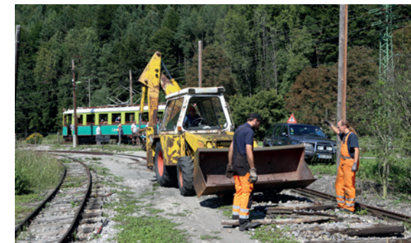
Am Sonntag, den 9. September werden die alten Schwellen in die Baggerschaufel geladen.
